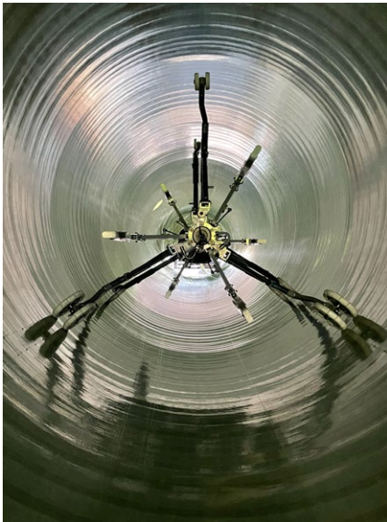
Stück für Stück fährt die UV-Anlage durch den aufgestellten Liner und härtet diesen aus
