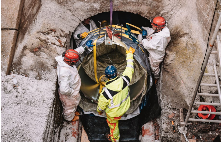
Jeder Liner-Einbau ist eine Teamleistung aus Expertenhand
