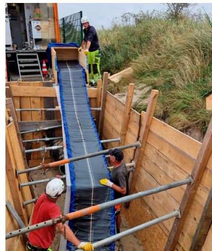
Die kompakten Transportmaße des Alphaliners begünstigten die Rohrinstandsetzung im UNESCO-Weltnaturerbe
